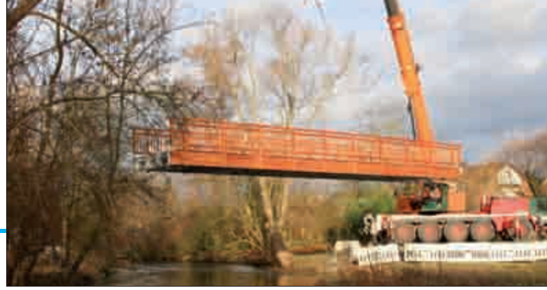
Die Brücke zur Schulwegsicherung ist bereits fest verankert.
