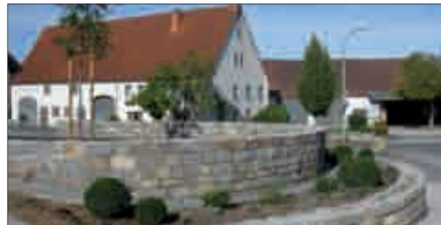
Neue Natursteinmauer (Kalkbruch) im Dorfzentrum Upsprunge
