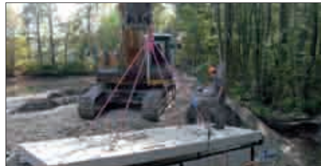
Gewässerbau an der Lutter in Bielefeld - Rahmenbauwerk
